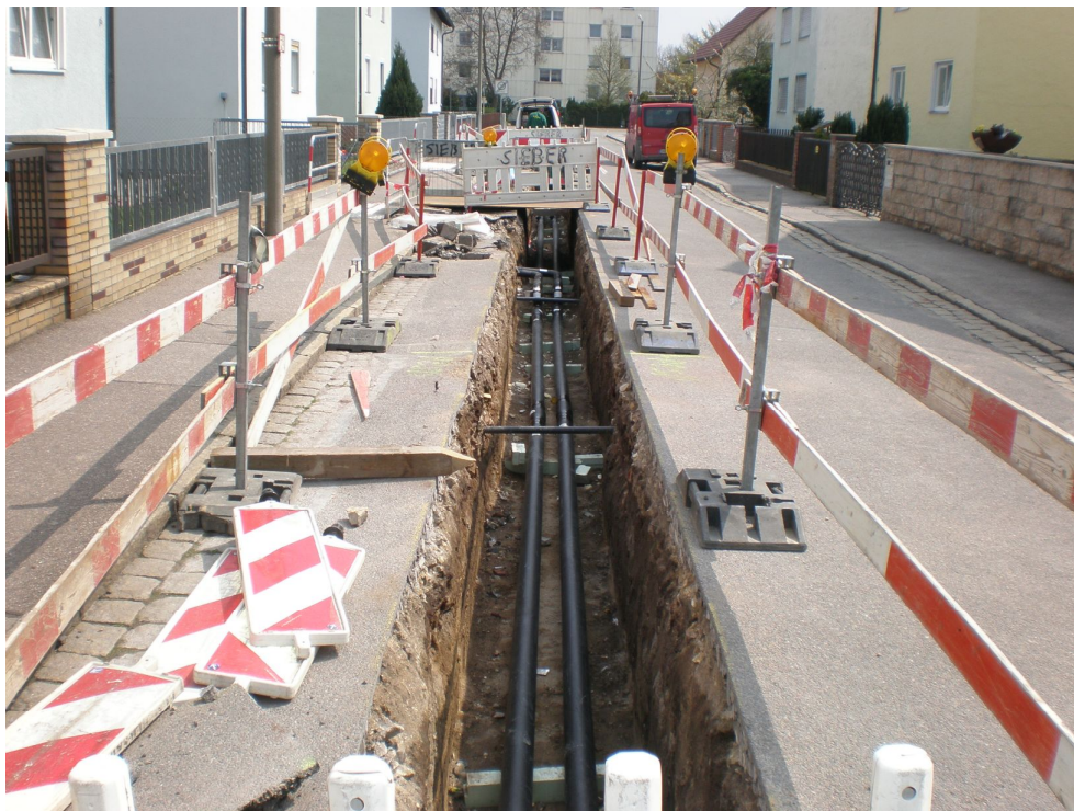
Einzelrohr der Dimension 2 x DN 40; Außendurchmesser 125 mm
