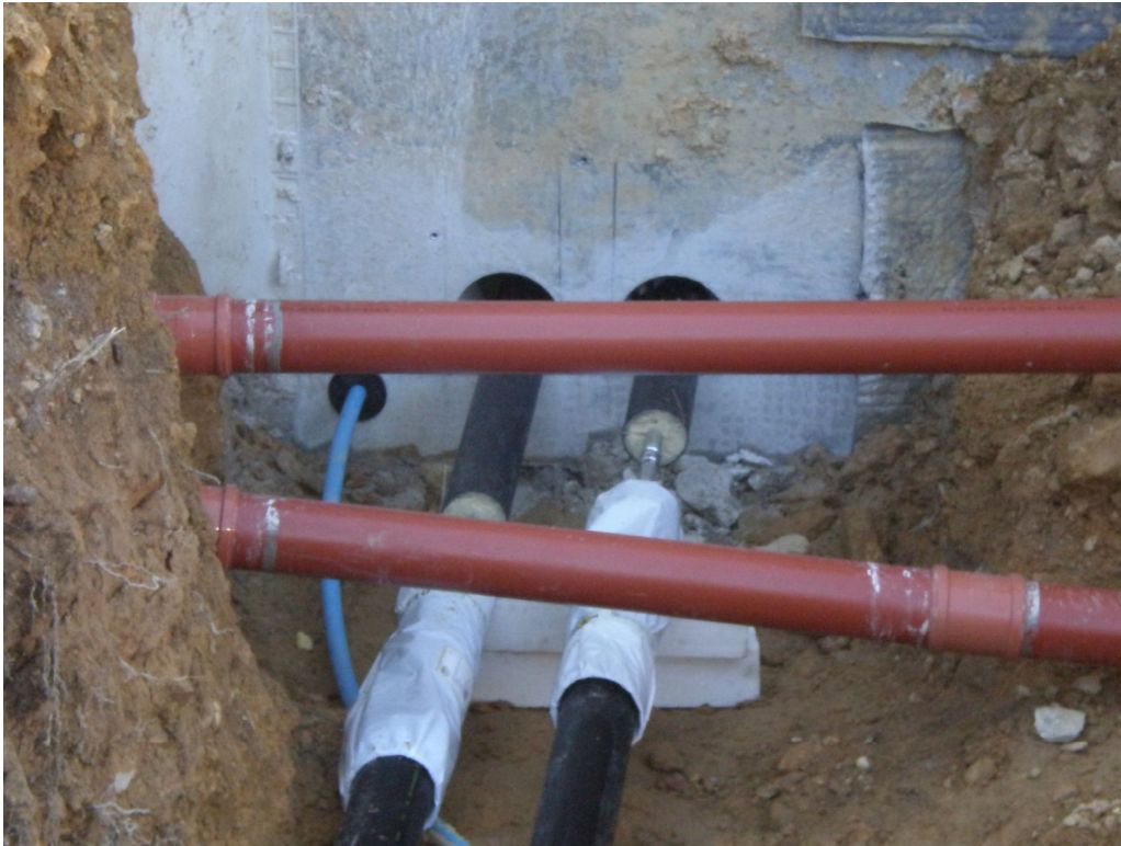
Einzelrohr der Dimension 2 x DN 40; Außendurchmesser 125 mm in Pressausführung bei bestimmten Netzteilen
