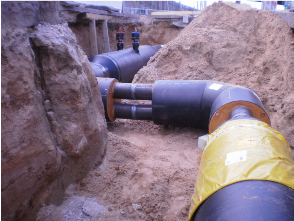
Doppelrohr der Dimension 2x DN 150; Außendurchmesser 450 mm
