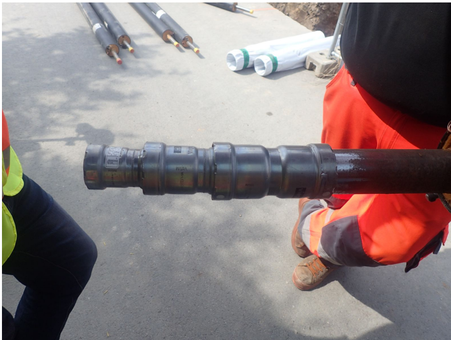
Einzelrohr der Dimension 2 x DN 40; Außendurchmesser 125 mm mit neuer Pressausführung für Standardrohre
